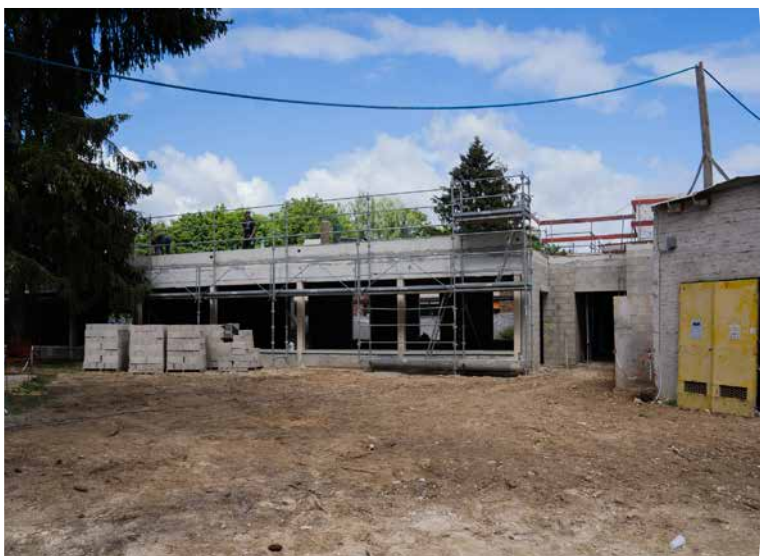
Extension de l'école du Parc 1 et 2
